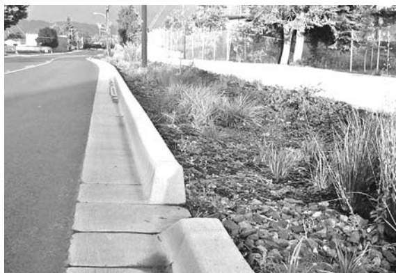
道路表面を流れる雨水は縁石カット部分から道路脇に設けられたグリーンインフラストラクチャーへ流入し、処理される (シアトル)
