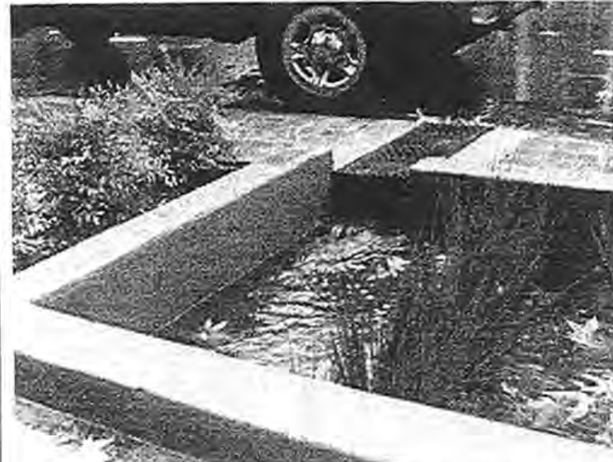
コンクリートの生物滞留池に道路の汚染流出水を浸透させ浄化する
