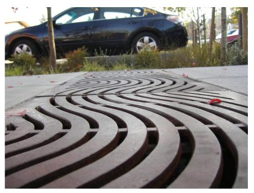
降雨排水を覆うふたのデザインが美しい。この水路は、降雨を縦樋経由で前方の植栽域へと導く。 そして植栽域には車道からも表面流出水が流入する。次頁の写真を参考に。
