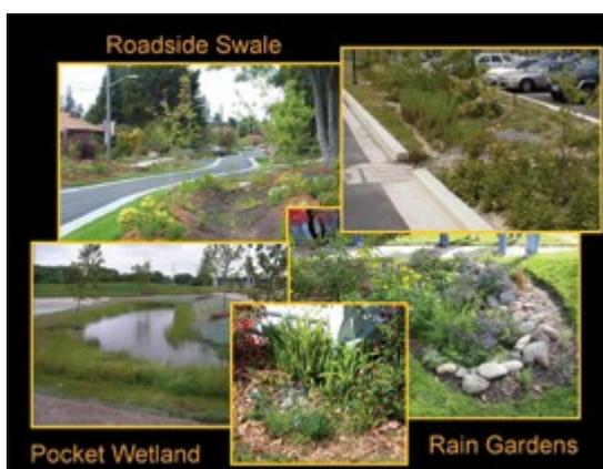
図 6 は、地形の中で実行された雨水集水技術を示す。路側と駐車場のくぼ地は舗装地域の端で実践される。
