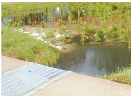
道路から既存雨水管渠へとつなぐ手前(直前)にバイオレテンション・セル装置をとりつけた改造:
