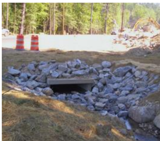
新しく構築された雨水排水管は、流出が道路の下を流れることを可能にする
