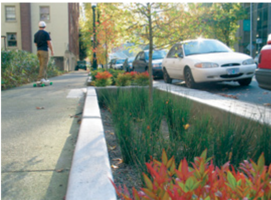
道路とサイドウォーク（歩道）の間に広がるランドスケープされたエリアは雨水を捕まえる
