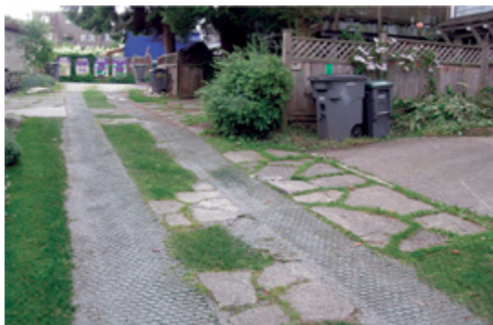
ブリティッシュコロンビア州バンクーバーの「田舎道」プログラムで、透水性舗装が都市の通路へと改装されられた。
